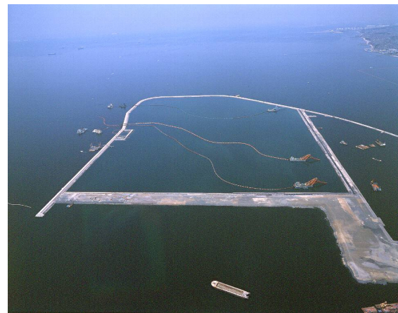
写真3 管中混合固化処理工法の施工状況(3船団) (中部国際空港; 最大圧送距離1,500m, 総施工量860万m 3 )
