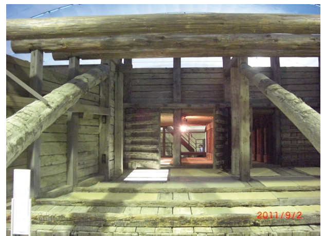
写真-3.12 技術の粋ともいえる金廻四間門樋
