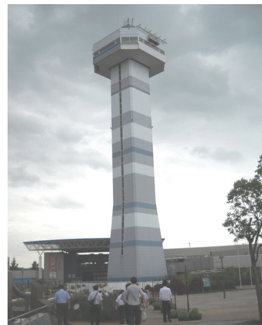
写真-3.6 65mの展望タワー(木曾三川公園)
