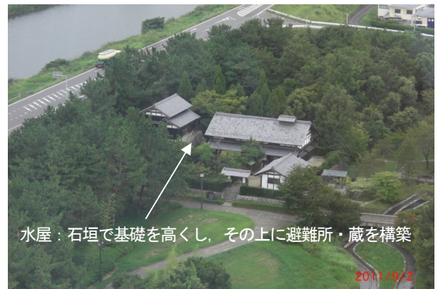
写真-3.10 輪中堤の中でさらに洪水対策としての水屋
