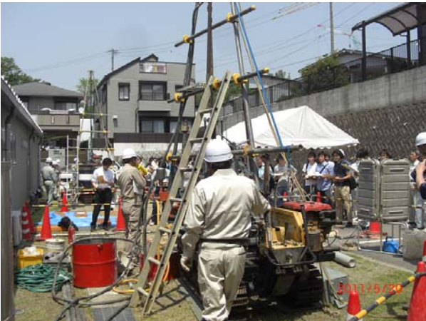
2台のボーリングマシンによる現場見学会の状況
