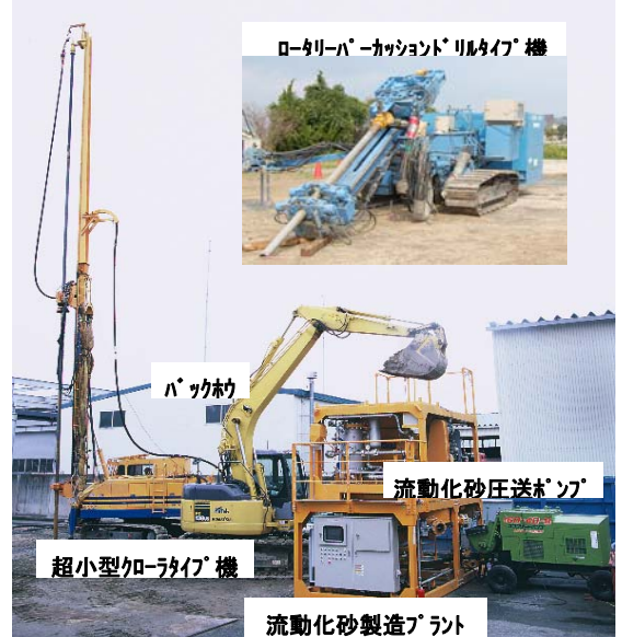
図 5 施工システム全景
