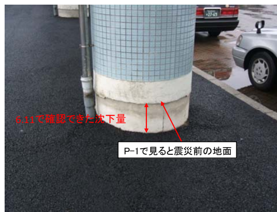
P-5 P-4のB柱の3ヶ月後(6月11日)の状況
