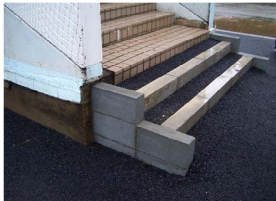
P-3 P-2と反対側歩行者用通路の階段増設
