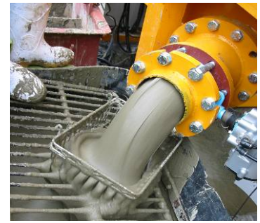
図 4 圧送される材料砂の状態
