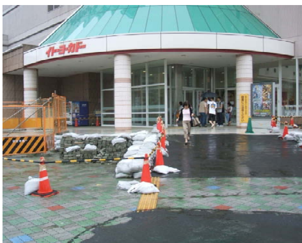
P-8 明海地区スーパーの正面入り口の段差
