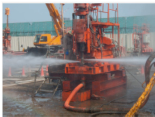
写真-2 ジェットクリート工法
