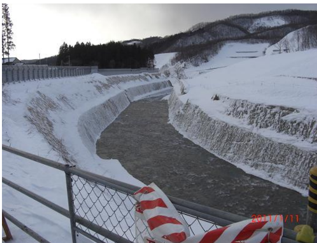
写真-4 本復旧完成後（下流側）
