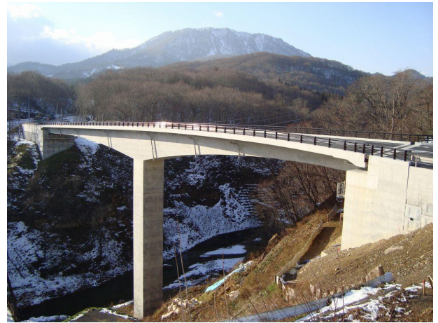
写真-8 完成した祭時大橋新橋（2010年12月18日に開通） （引用元：http://kenplatz.nikkeibp.co.jp）
