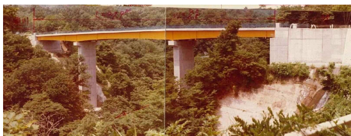
写真-5 地震発生前の祭時大橋 3)
