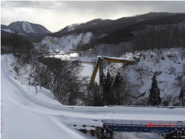
写真-7 現在の祭時大橋（この状態で保存されるとのこと） （手前は、仮設の祭時大橋）
