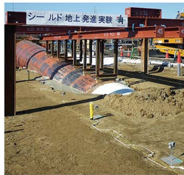
写真-5 シールド地上発進実験
