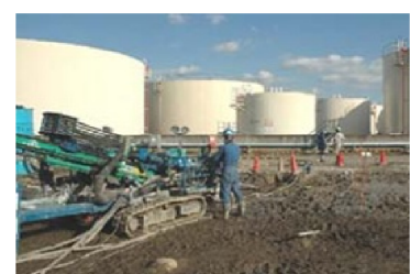
写真-3 グランドフレックスモール 工法の適用事例
