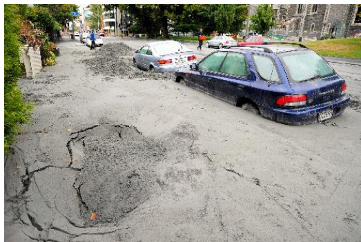
図-1 液状化により発生した砂で埋まった道路
