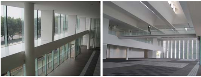
(a) 超高強度 CFT 柱 (b) スリムクリートブリッジ 写真-2 高強度材料による部材
